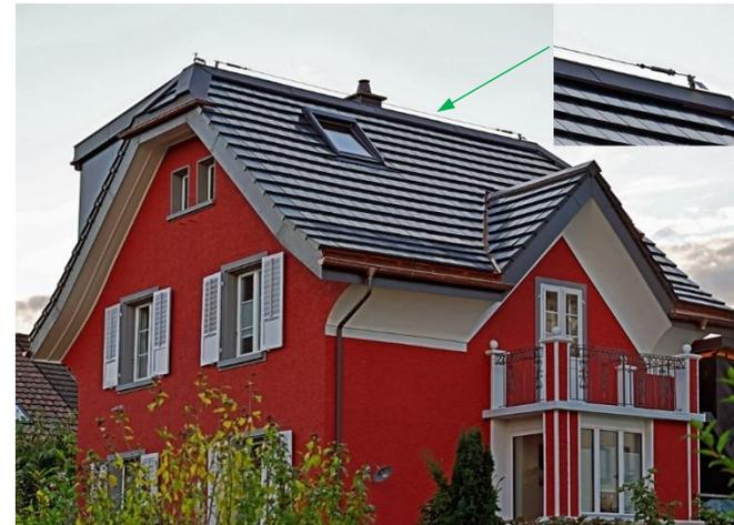
Bild 2: Geneigtes Dach mit Solarziegeln und permanentem Seilsystem über dem Dachfirst zum Anschlagen der PSAgA bei Instandhaltungsarbeiten (Quelle: Suva/MB/MGR)
