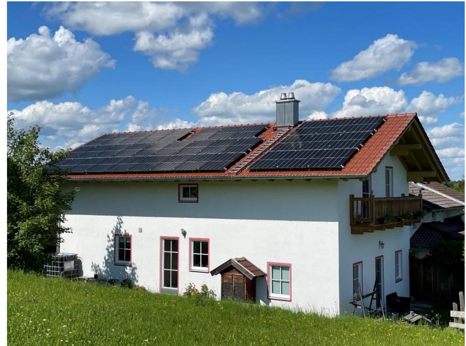
Bild 1: Geneigtes Dach mit PV-Anlage und fest montierter Dachleiter (Quelle: BG Bau/PM)
