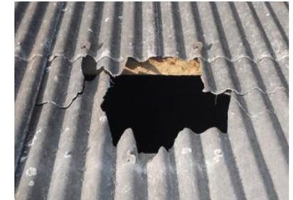
Faserzementwellplatte nach dem Durchbruch einer Person (Bild: Suva)
