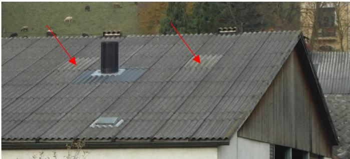
Dach aus Faserzement- und Lichtwellplatten
