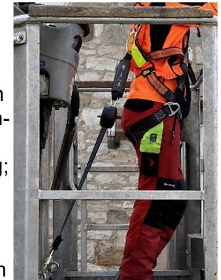
Bild 2: Verbindungsmittel beim Arbeiten so kurz wie möglich
