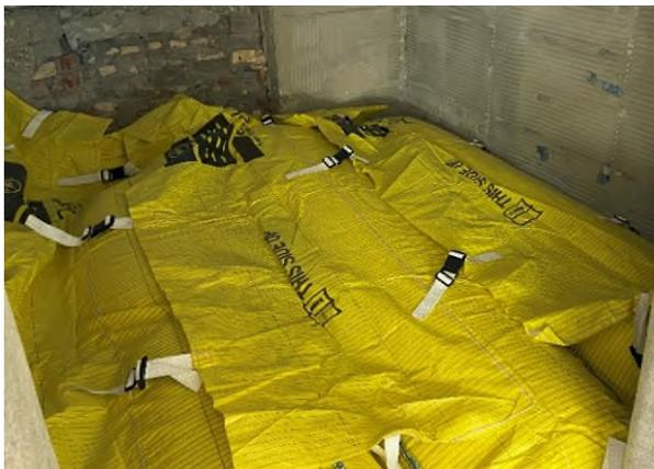
Bild 1: Satt in den Raum eingepasste SLS mit Überlappungen über den Fugen (Bild: Suva)
